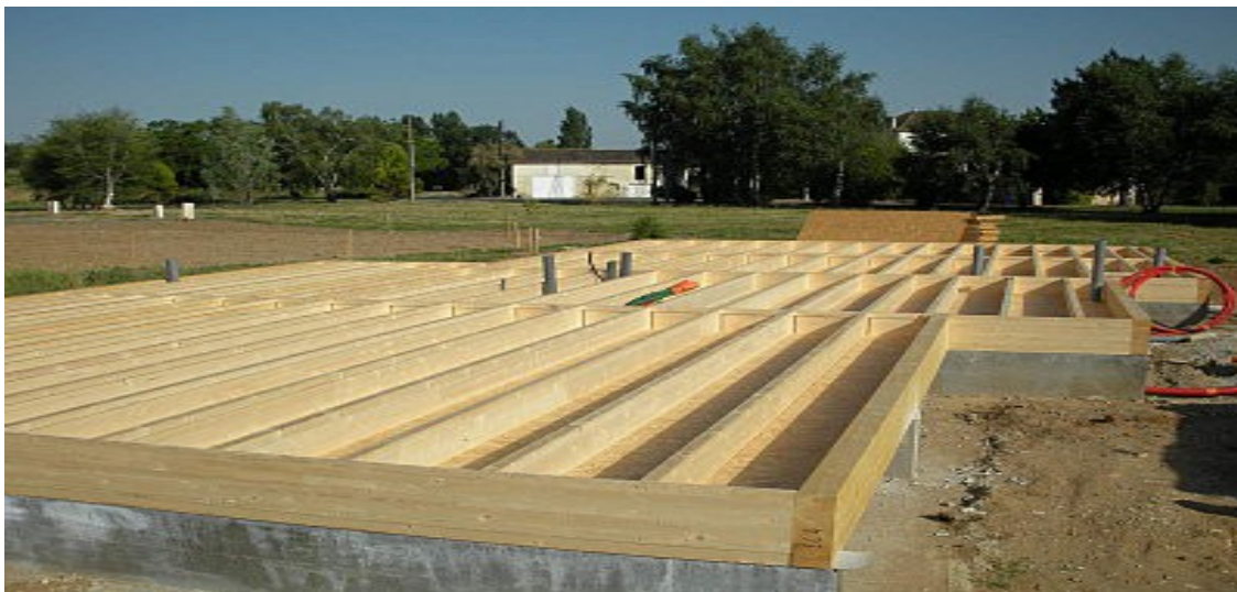
Montage de la plateforme sur vide sanitaire (En Option)
