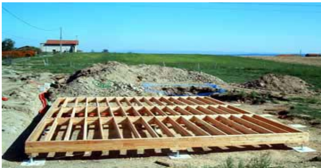
Montage de la Plateforme sur Pieux métalliques (Avec Isolation du Terrain)
